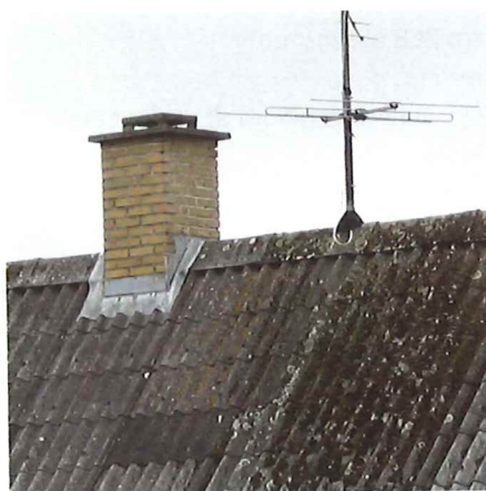
Ældre eternittage indeholder som oftest asbest.
