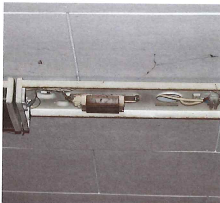
Ældre armaturer til lysstofrør indeholder ofte PCB.
