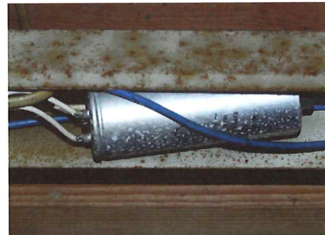
Ældre kondensatorer indeholder ofte PCB.
