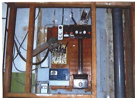
Eltavle kan indeholde relæer og andet elektrisk udstyr, der kan indeholde PCB og kviksvølv.
