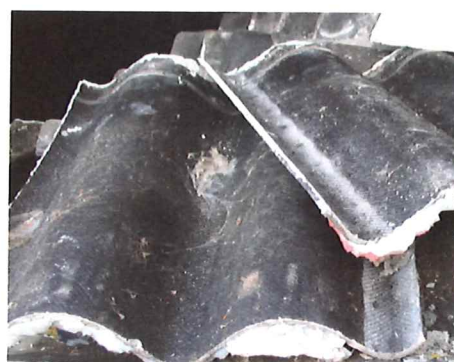
Eternitplader. Ældre eternitplader indeholder asbest. Pladerne skal deponeres, og må ikke slås i stykker.
